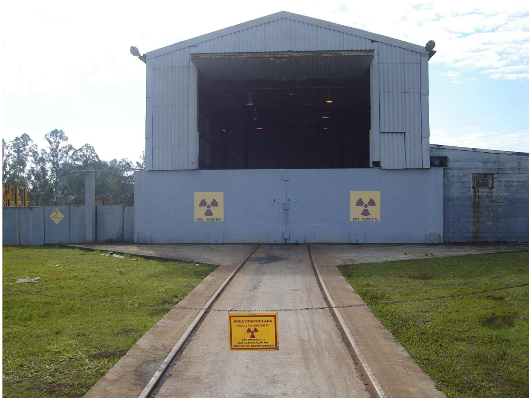
Figura 28 - Local da realização do Ensaio por Radiologia
